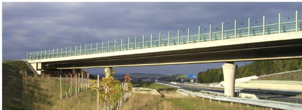
Obrázek č. 4. Jižní část silničního obchvatu města Plzně, která značně ztížila cestu pro pěší i cyklisty ke zřícenině hradu Radyně. Stavbu dálnice a obchvatu Plzně provázela dlouhá diskuze k jejich umístění. Přesto byla nakonec naplánována tak, že bylo nutné prorazit tunel v kopci Valík.
